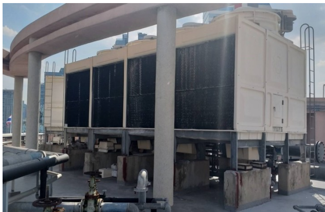
ภาพแสดง ระบบระบายความร้อนด้วยน้ำของเครื่องปรับอากาศ
