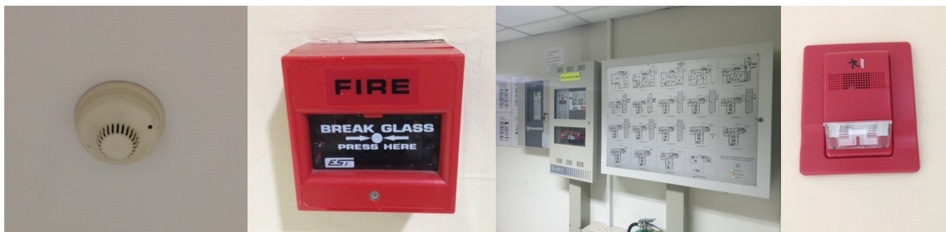
ภาพแสดง อุปกรณ์แจ้งเหตุเพลิงไหม้
