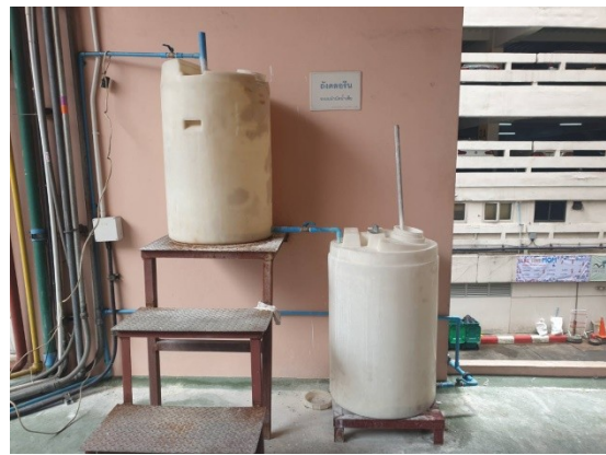
ภาพแสดง ระบบบำบัดน้ำเสียและถังเติมคลอรีน อาคารหมอแวลส์
